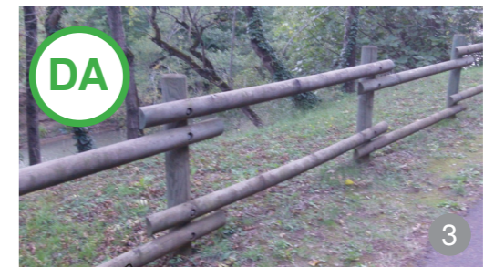
AȘA DA: Imprejmuiri ușor de realizat într-un timp scurt din materiale naturale
