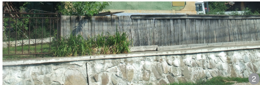
2 Împrejmuire înălțată pe un perete de susținere a terenului din blocuri mari de piatră și gard din scânduri de lemn dispuse vertical protejate la partea superioară de intemperii
