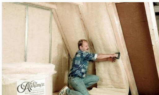
Montarea termoizolației din fibre de lână de oaie
