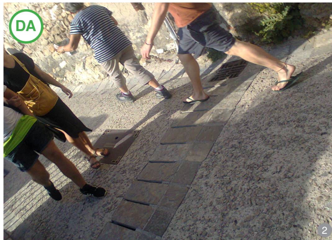
AȘA DA: Rezolvări pentru colectarea apelor pluviale și transversale pe drum duc la o durată mai mare de folosire chiar și a suprafețelor de drenare.
