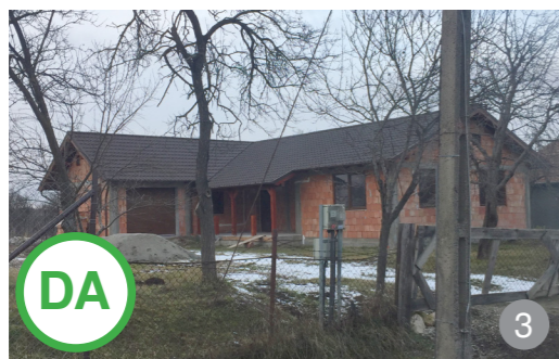
AȘA DA: Târnaț parțial la o construcție nouă
