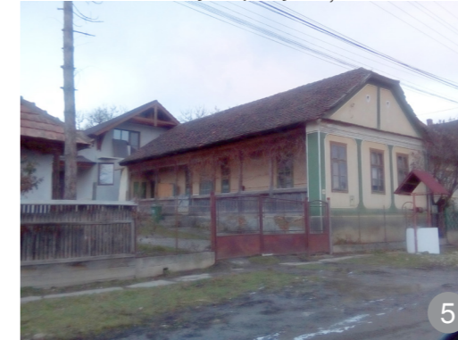
Acoperiș în două ape teșit – întâlnit în comunele Șamșud și Dobrin
