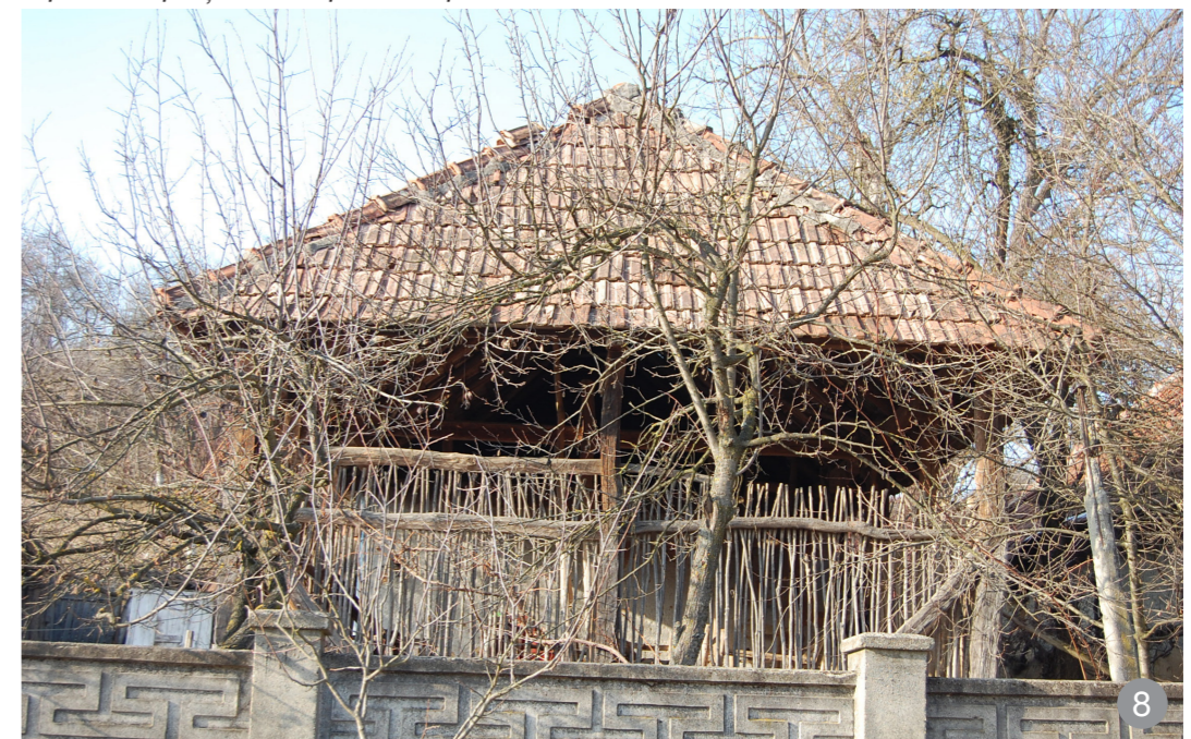
Închideri ușoare din nuiiele la o șură din Sălaj
