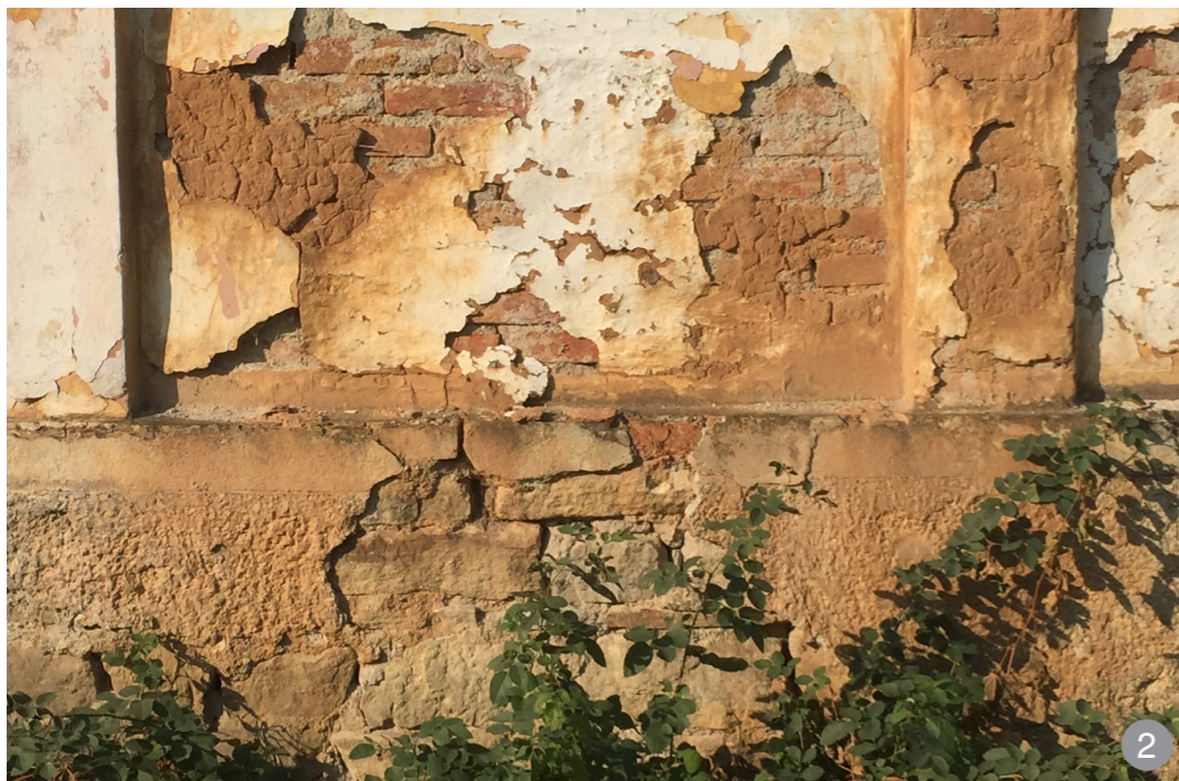
Fundație din lespezi sub pereți din cărămidă
