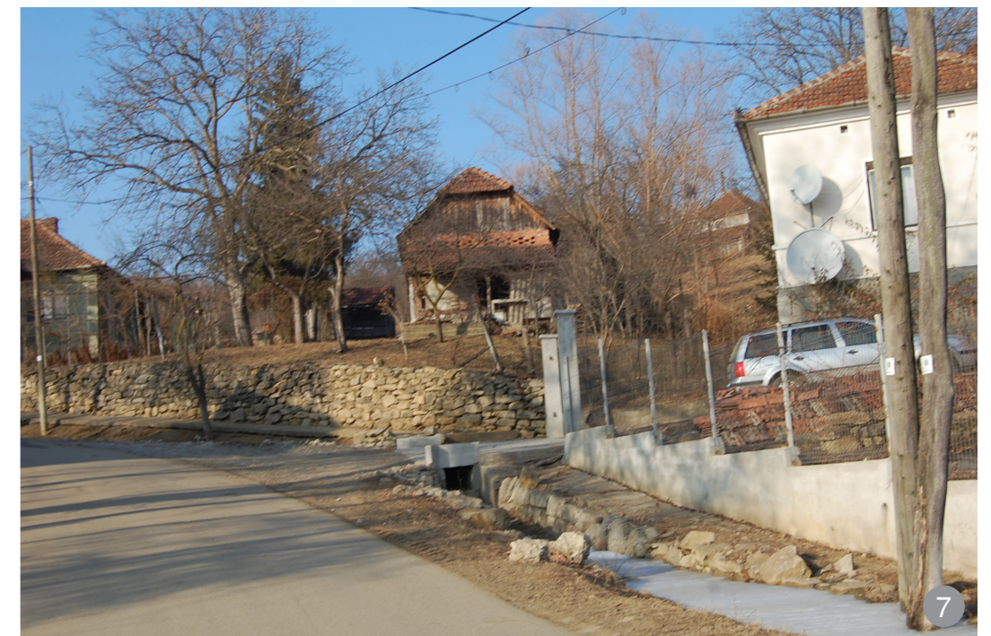
Marginile șanțului pot fi captușite cu piatră sau se pot prevedea rigole înierbate.
