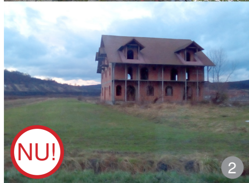
AȘA NU: Nu recomandăm extinderea târnațului și la mansardă sau la etajele superioare.
