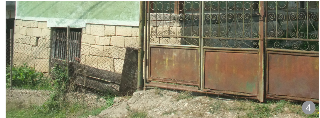
Fundație din blocuri de piatră
