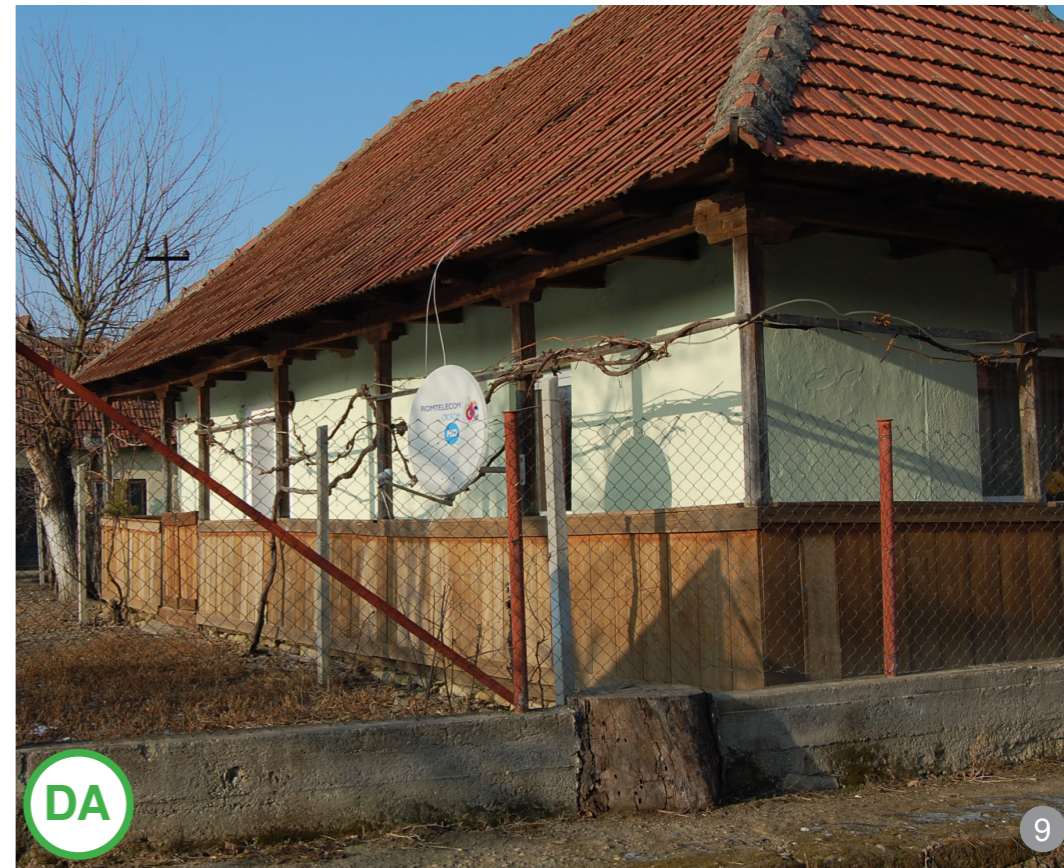
AȘA DA: Recomandăm reabilitarea balustradei sau construirea unei noi balustrade din materiale tradiționale acolo unde aceasta nu există și se consideră necesară de către proprietari.
