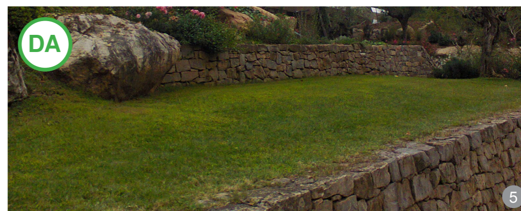
Dacă sunt necesare terasările, se pot realiza cu folosirea cât mai puțină a betonului.
