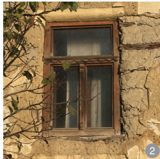
Fereastră tradițională amplasată la fața exterioară a zidului cu traversa decorată în perete din pământ lipit între „lobde”
