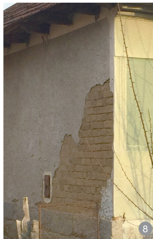
Perete din zidărie de cărămidă arsă
