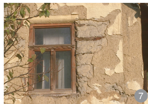
Perete cu pământ lipit între „lobde” („lețuri”)
