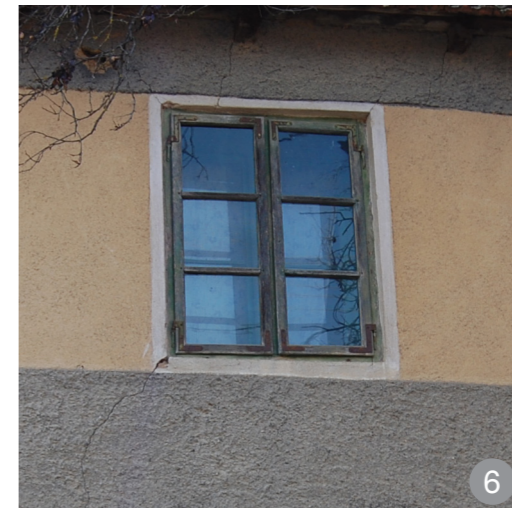
Ferestre simple cu canaturile mobile împărțite în trei, mai ales la case vechi de secol XIX, mai sunt păstrate și azi în număr mare în zona Sălaj.
