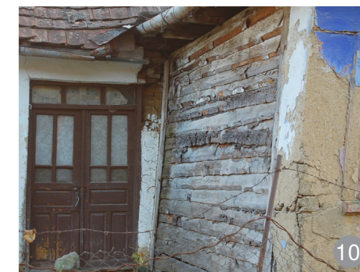
Perete din scânduri de lemn suprapuse tip caplama, întâlnit rar
