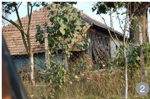
Șură cu acoperiș în patru ape cu o polată la intrarea în poiată și cel mai adesea cu șura deschisă pe latura scurtă
