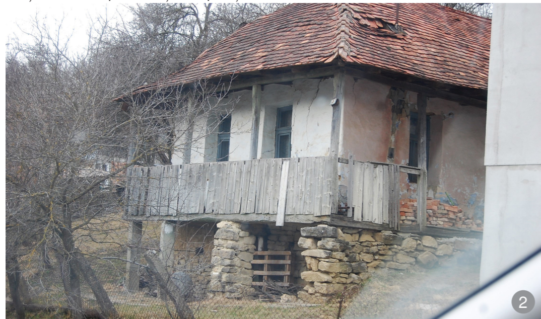
Locuință așezată pe pantă la care diferența de nivel este folosită ca pivniță
