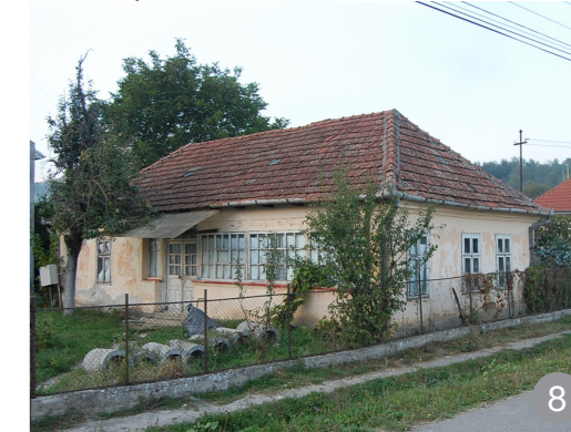
Închiderea târnațului elimină spațiul protejat dintre interior și exterior, fapt pentru care apar acoperiri suplimentare improvizate.
