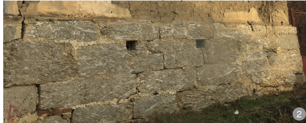
Fundație din blocuri de mică
