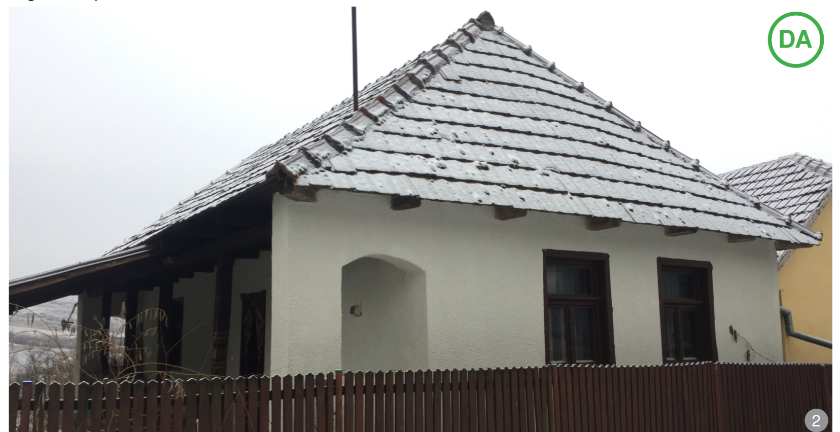
AȘA DA: Recomandăm reabilitarea pereților caselor tradiționale și refacerea finisajelor în spiritul specificului local acolo unde acestea sunt degradate de trecerea timpului.
