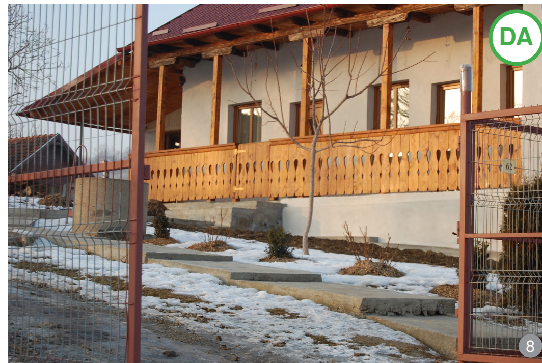
AȘA DA: Recomandăm reabilitarea târnațului în spiritul specificului local dacă acesta este degradat de trecerea timpului.
