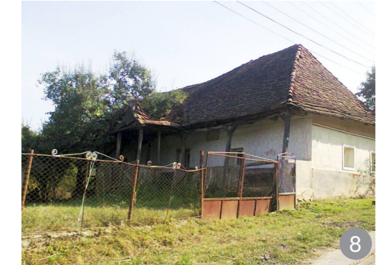
Acoperiș în patru ape înalt (cu unghi mai mare de 45 grade) acoperit cu țiglă solzi
