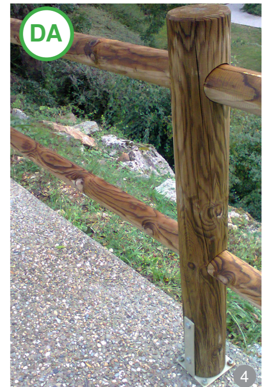
AȘA DA: Soluții puțin industrializate pot asigura rezolvări rapide a lungimilor mari de împrejmuire.
