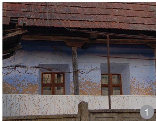
Ferestre cu șpaletii teșiți pentru a intra mai multă lumină în zidurile groase din pământ
