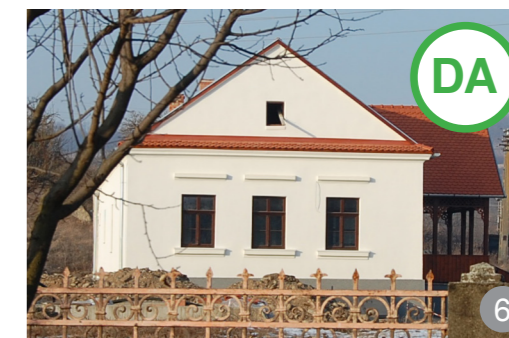
6 AȘA DA: Reabilitarea unei case presupune păstrarea semnificației culturale a detaliilor decorative existente. Dacă se adoptă limbajele clasice ar trebui păstrate elementele de compoziție și ritm de travee.
