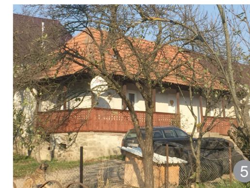
Târnaț din lemn pe două laturi în zone cu teren în pantă cu balustradă plină din scânduri din lemn sculptate și pivniță sub casă
