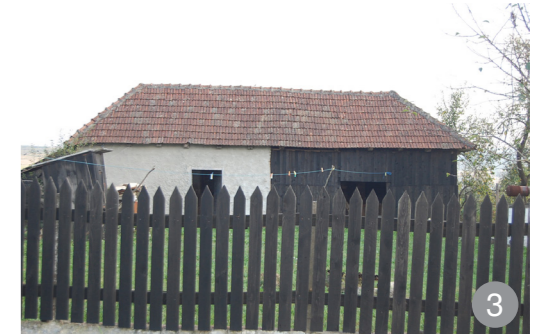
3 Intervenție la împrejmuire care păstrează tipul de material (lemnul), dar nu și formele specifice
