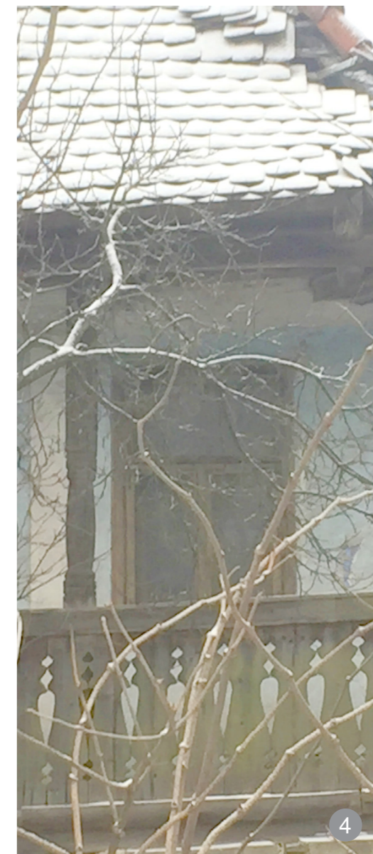
Travee la o locuință din satul Mirșid
