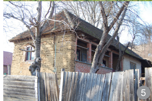
Perete din cărămidă nearsă
