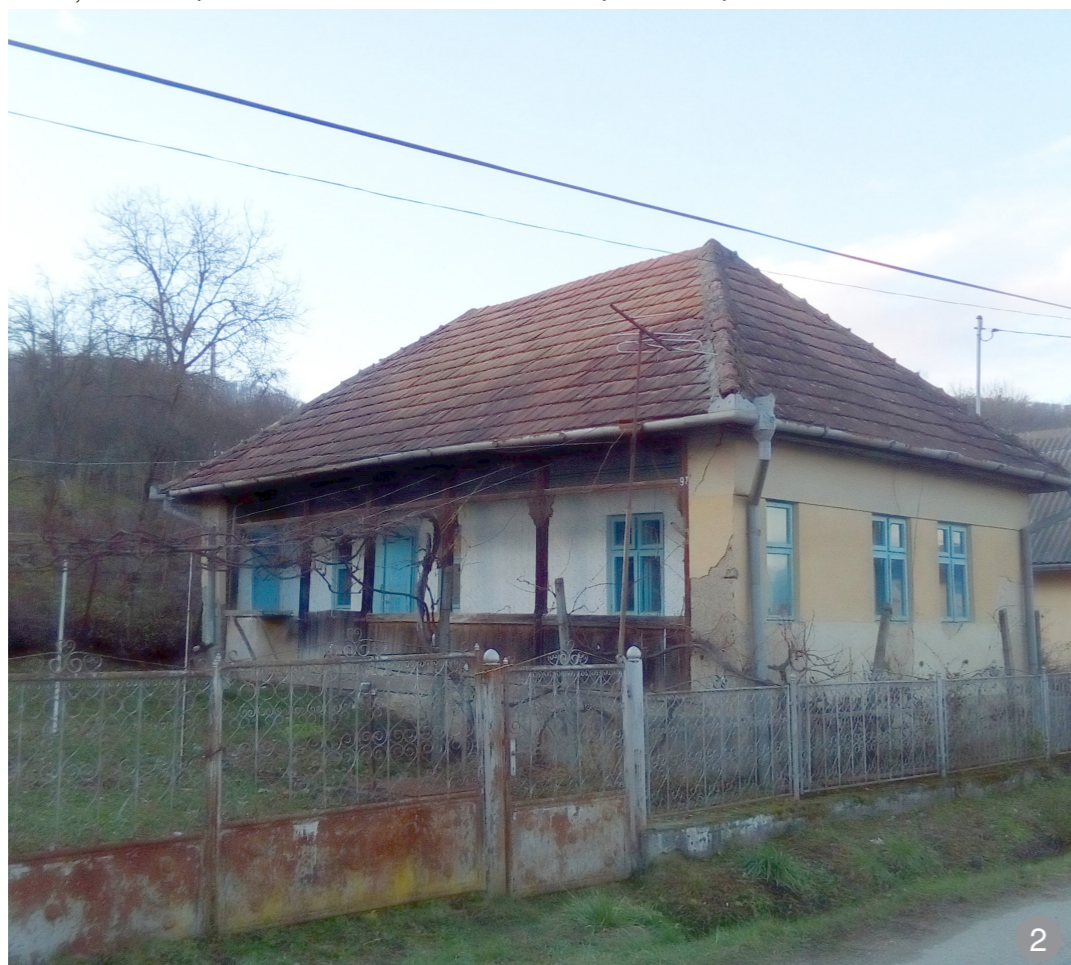
Târnaț din lemn pe o latură închis pe laterale cu zidărie
