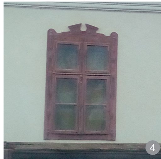
Tâmplărie cu șase ochiuri de geam, ancadrament cu urechi și fronton triunghiular întrerupt
