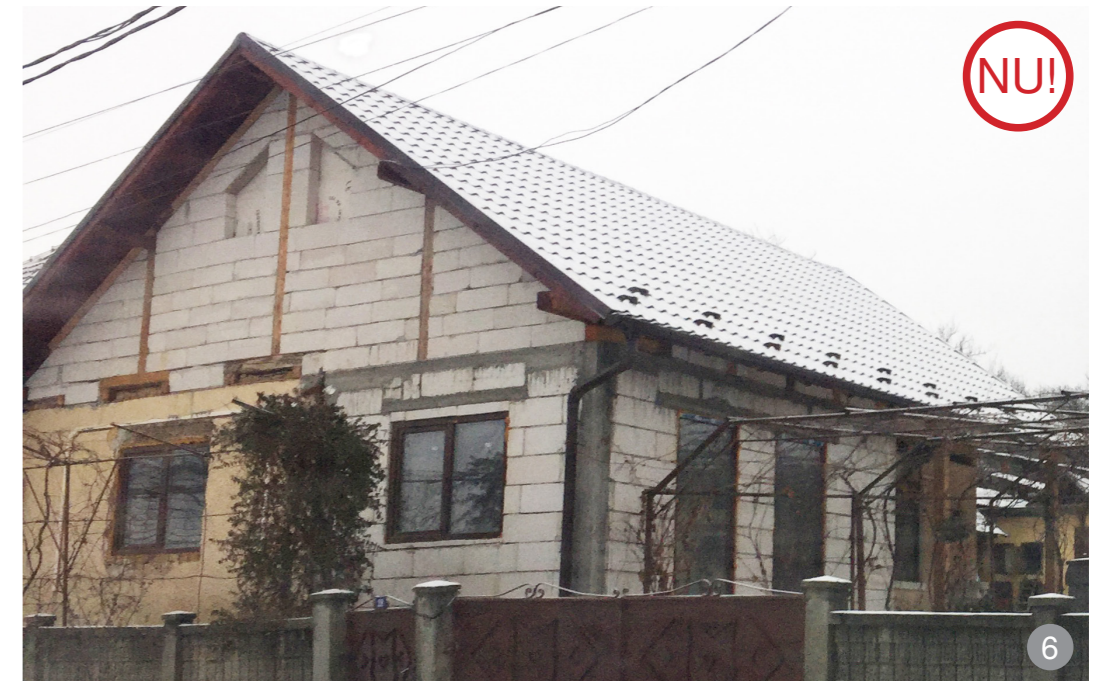
AȘA NU: Se interzice extinderea lățimii casei măsurată la stradă. Specificul local al străzilor este dat de dimensiunea caselor cu o singură încăpere la stradă (există și sate cu case tradiționale cu două încăperi la stradă, dar nu au fronton, ci o cornișă și o apă către stradă). Dacă spațiul unei case de acest tip se consideră insuficient, recomandăm refuncționalizarea șurilor pentru a obține mai mult spațiu util.
