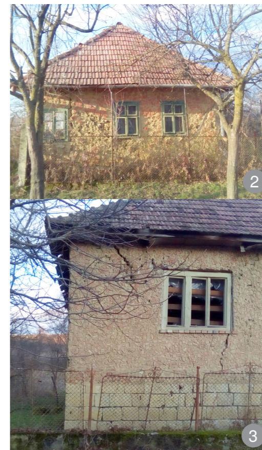
Perete finisat cu țiglă reciclată pentru protejarea la umiditate a zidului
