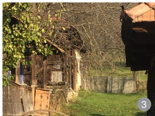
Împrejmuire care delimitează gospodăria de grădina din spate
