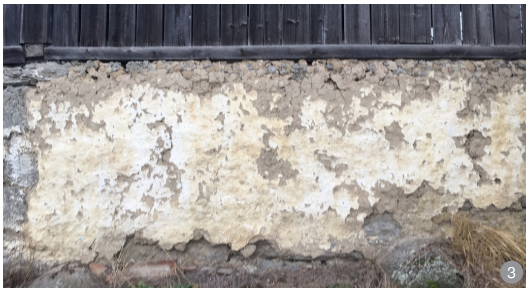
Fundație din piatră tencuită cu pământ
