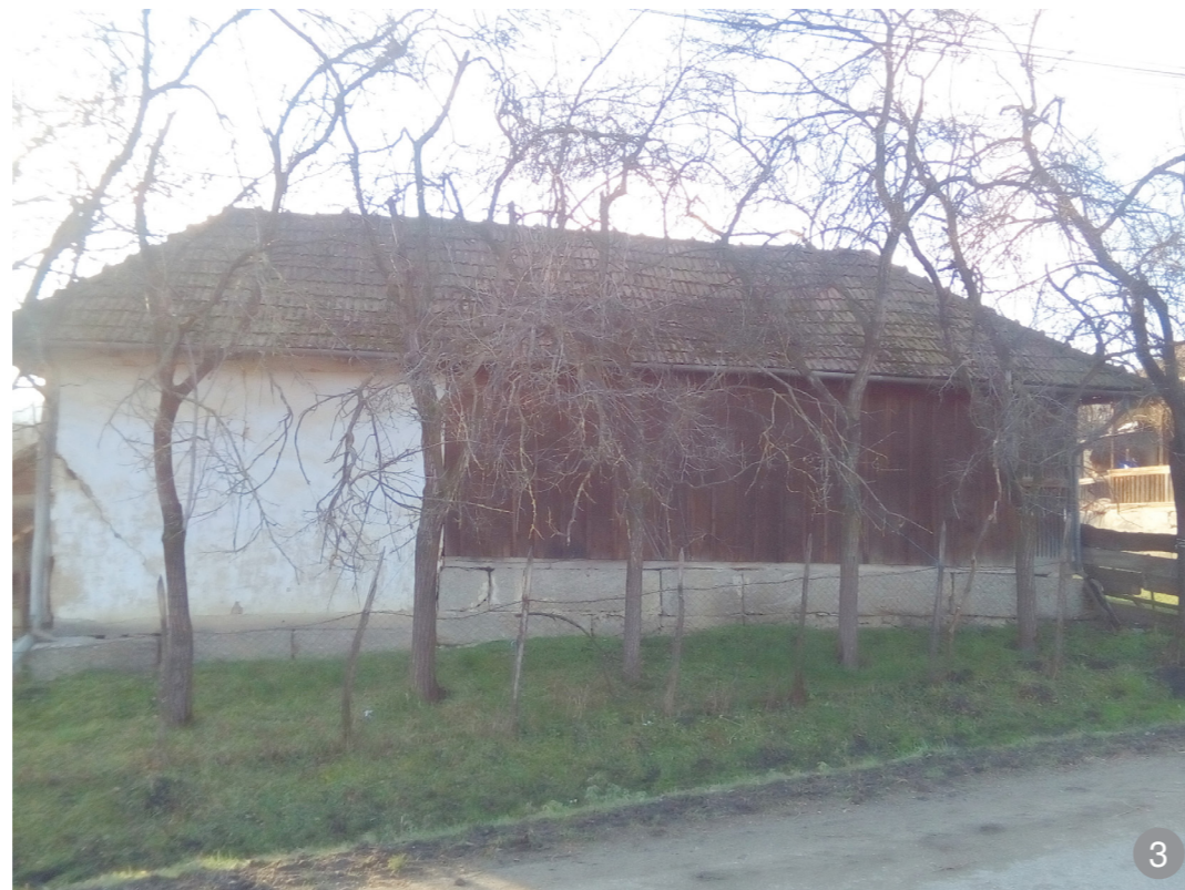
Fundație din blocuri mari de piatră
