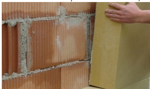
Montarea termoizolației din fibre de lemn
