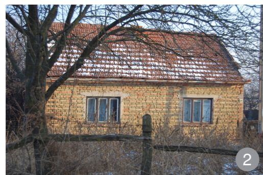
Perete din straturi alternante de cărămidă arsă și cărămidă nearsă
