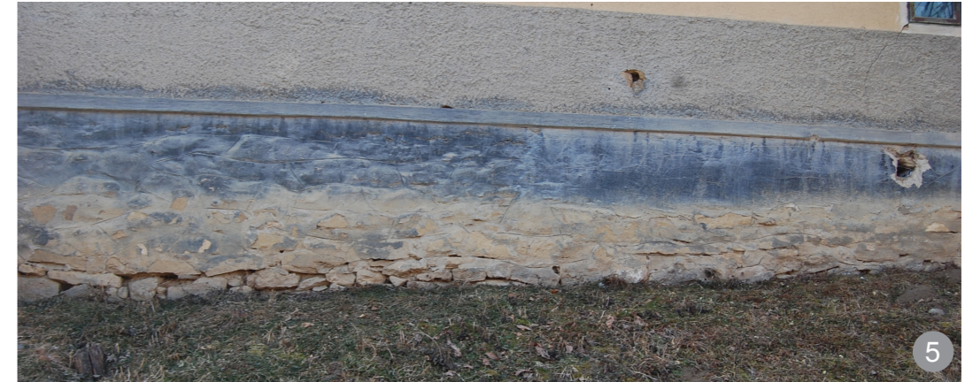
Fundație din lespezi de piatră tencuite
