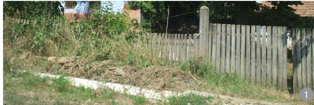
1 Împrejmuire și poartă din scânduri de lemn dispuse vertical
