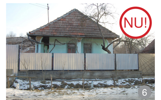
6 AȘA NU: Nu recomandăm împrejmuiiri noi realizate din tablă sau materiale denumite generic „plasticuri”.
