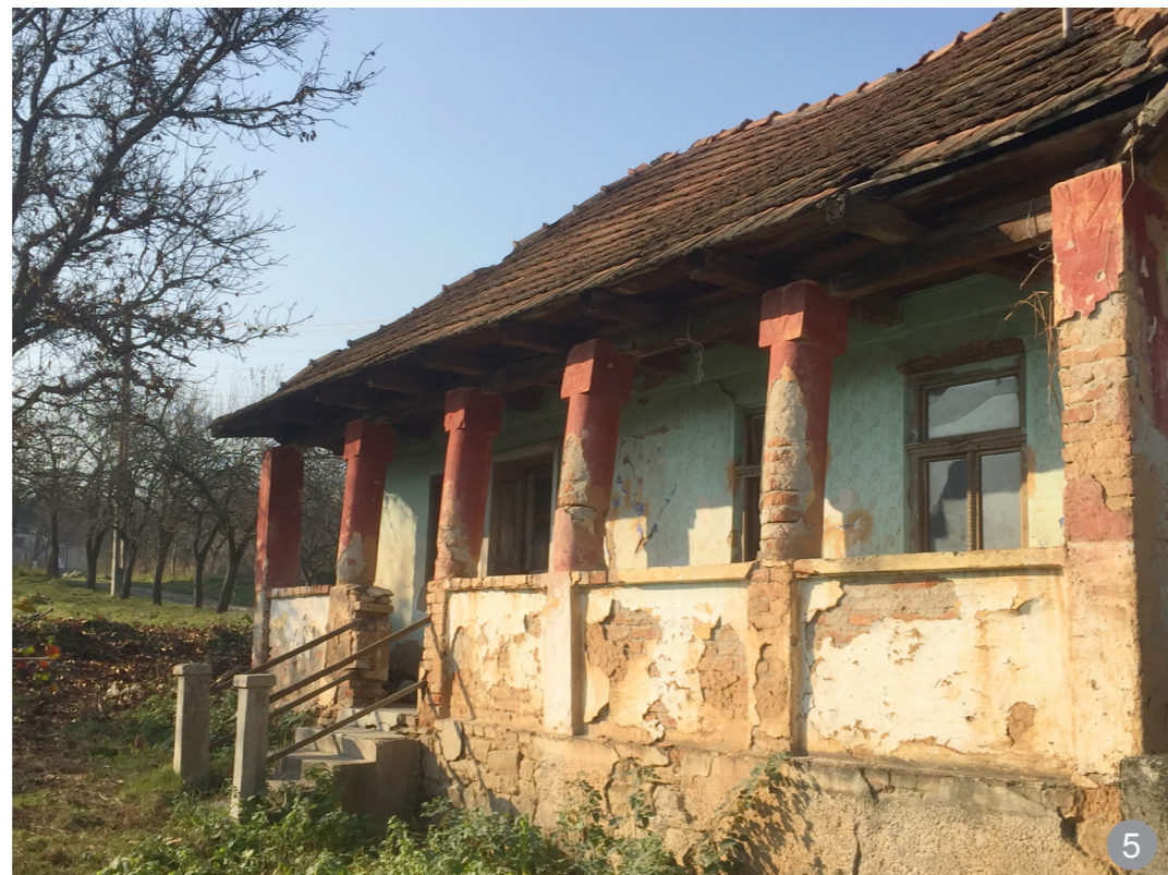
Târnaț cu stâlpi din zidărie
