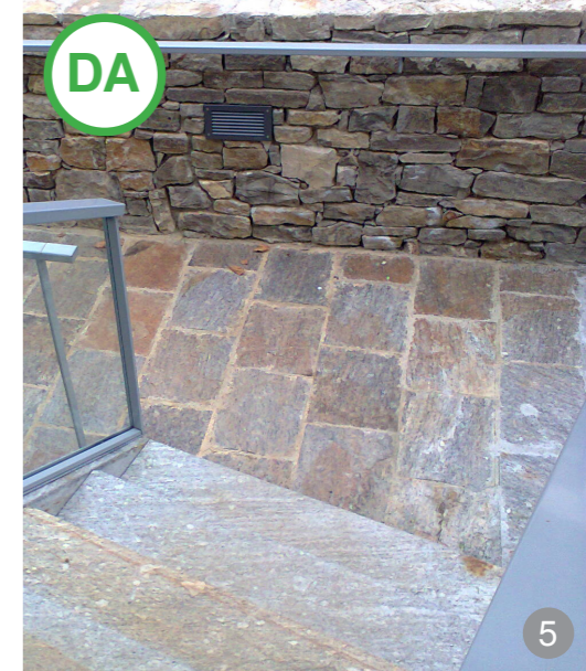
AȘA DA: Trepte masive din piatră și parapet din piatră cu rosturi adâncite pot acompania cu succes amenajările publice sau private.
