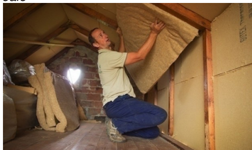
Montarea termoizolației din fibre de cânepă
