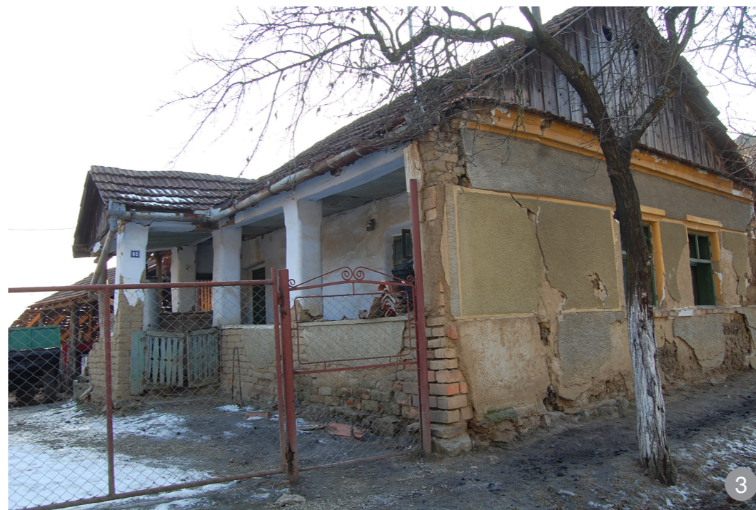
Târnaț cu coloane masive din zidărie și frigurie închis pe fațada dinspre drum
