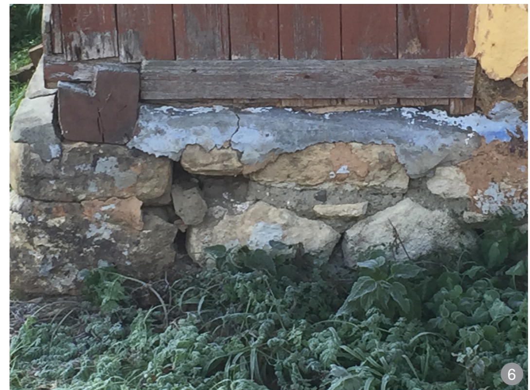
Fundație din piatră zidită
