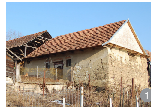
În lipsa lemnului de conifere, pereții erau confecționați din materiale locale precum văioagele lipite.
